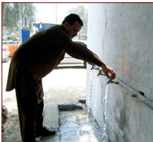
Wasserverteilerstelle Chowk Sarwar Shaheed
