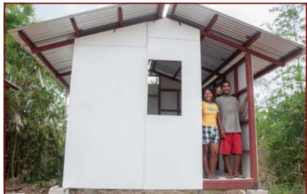
Eine Familie im Rohbau ihres neuen Hauses
